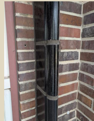
Eingebaute Formsteine in der Fassade
